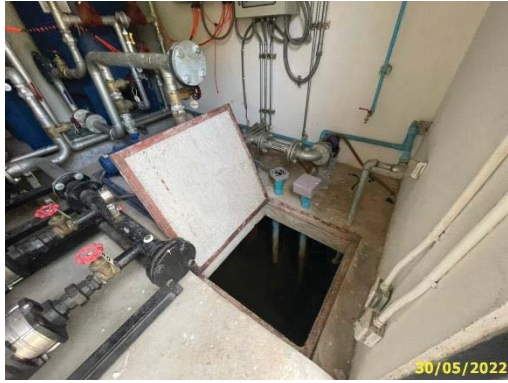
ถังเก็บน้ำสำรองอาคารห้องเครื่อง
