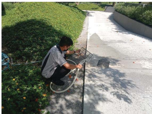
ล้างแผ่นกรองอากาศเครื่องปรับอากาศ
